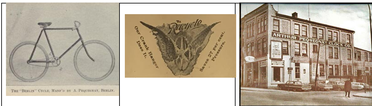
La photo de l'édifice date de 1964, juste avant sa démolition.
