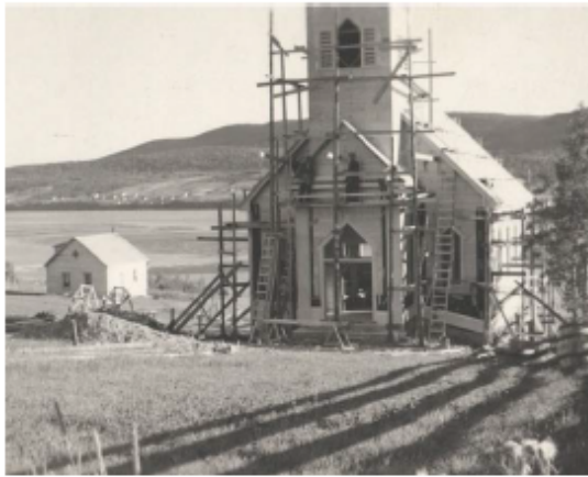
Eglise presbytérienne de Sainte-Majorique en construction
